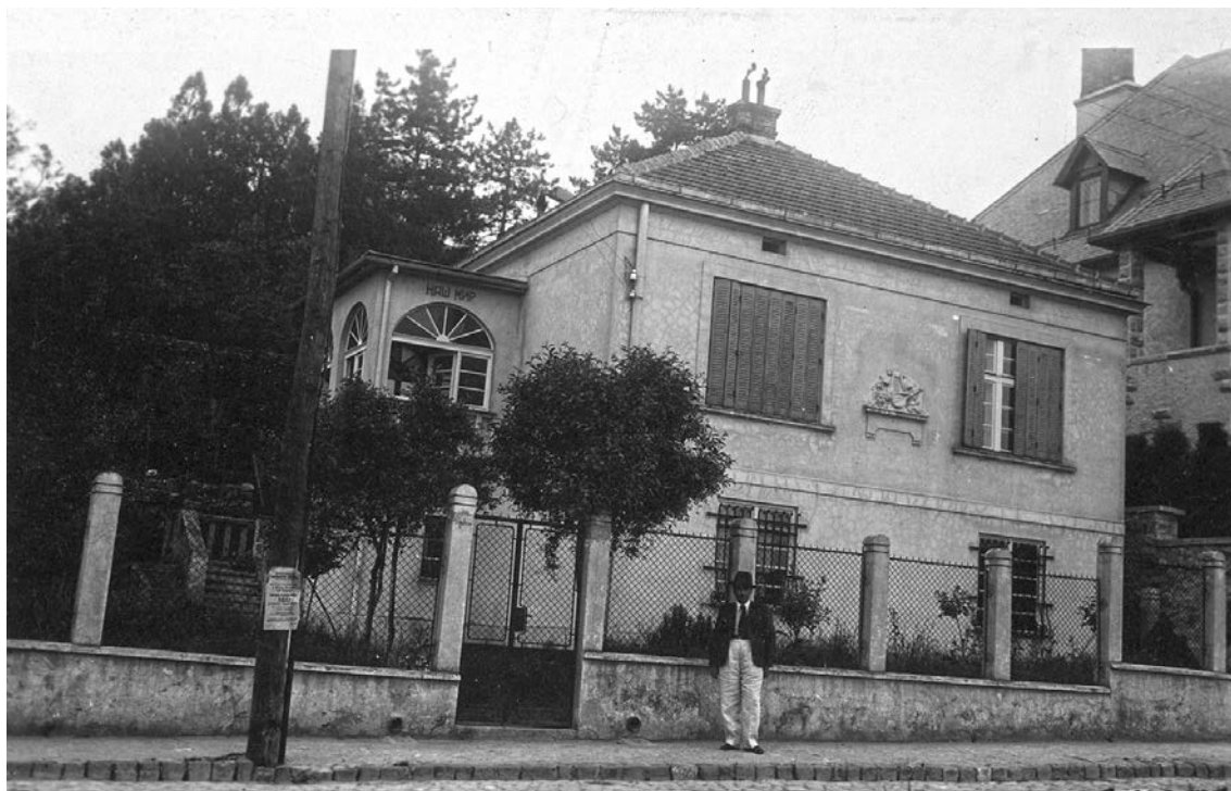
Слика 10. Кућа на Булевару војводе Мишића број 69, срушена 1936. године (Ур_2430)
